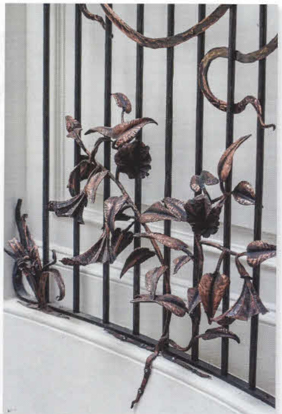
Maison Art Nouveau Railing, and detail
